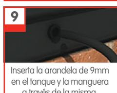
Inserta la arandela de 9mm en el tanque y la manguera a través de la misma.
